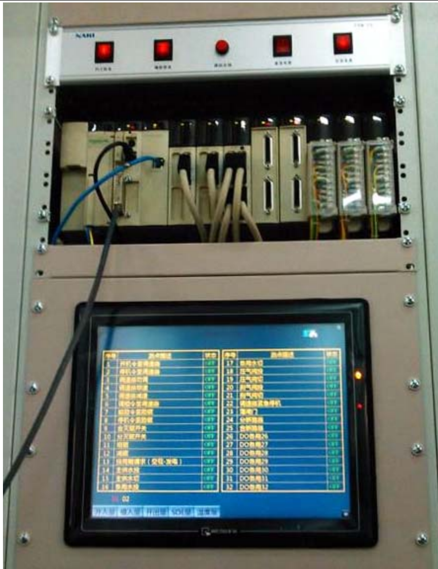
图 2 现地控制单元实物照片
